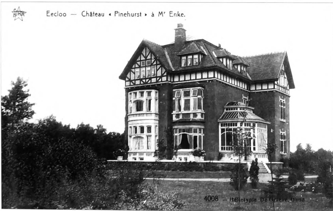
Villa Pinehurst, gebouwd in 1904 door Hermann Peter Enke/Peter Armstrong en later bewoond door het echtpaar Stradiot-Duvieusart. Vandaag doet de woning dienst als bejaardentehuis (Stadsarchief Eeklo, D 201).
