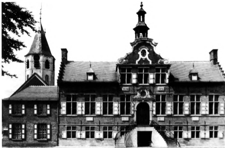
Stadhuis van Kaprijke na de restauratie (1986).
