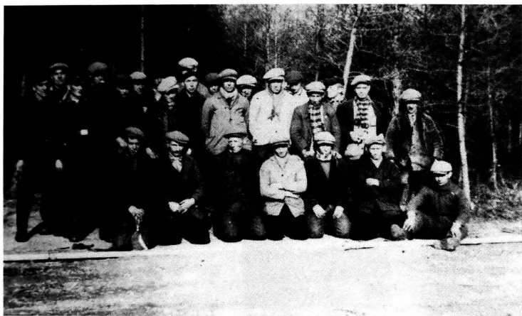
1940 - Onder toezicht van manschappen van het Feldbauamt verrichten talrijke omwonende personen allerlei werkzaamheden op het terrein. Bemerkt hoe reeds een waterleidingsnet wordt aangelegd. (Verz. R. Moelaert)
