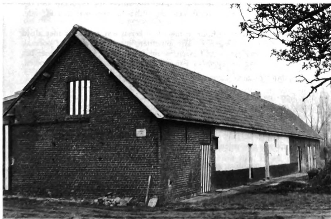
Het Goed te Meerlare : Het stalgebouw - 1772. De aanbouwen weerszijden dagt. einde 19 e begin 20 e eeuw.
