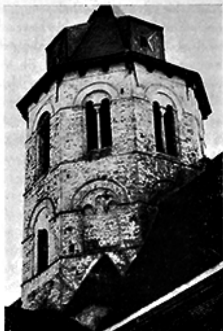
Adegem, de romaanse vieringstoren
